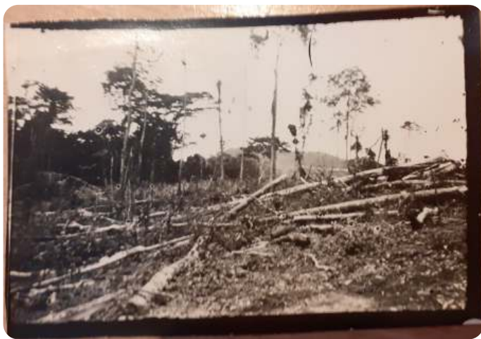
"Okoyong, Mamfe. De nieuwe Missie. Het omhakken en opruimen. June '34" Er wordt oerwoud gekapt voor de bouw van de eerste parochiekerk in Mamfe.
