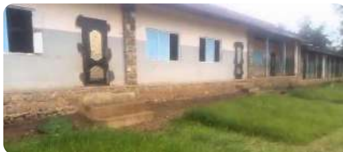
Na de renovatie: nieuwe luiken, nieuwe deuren die goed sluiten, nieuw dak, en de muren zijn fris geverfd.
